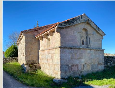
En la parte posterior, en la capilla, se abre una ventana bajo arco de medio punto liso, apoyado en una columna acodillada a cada lado.
