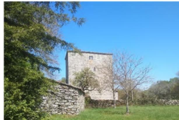
Tiene escudos de armas de los Arias, los Taboada y de los Ribadeneira. La planta tiene forma de "L", a partir de la torre cuadrada a la que se le adosa el pazo barroco, construido sobre dependencias anteriores. Los muros son de mampostería y sillaría de granito, y la cubierta de teja a dos y cuatro aguas
